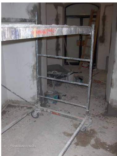
Građevinski radovi u zapadnom dijelu Muzeja za potrebe postava spomen zbirke Domovinskog rata
