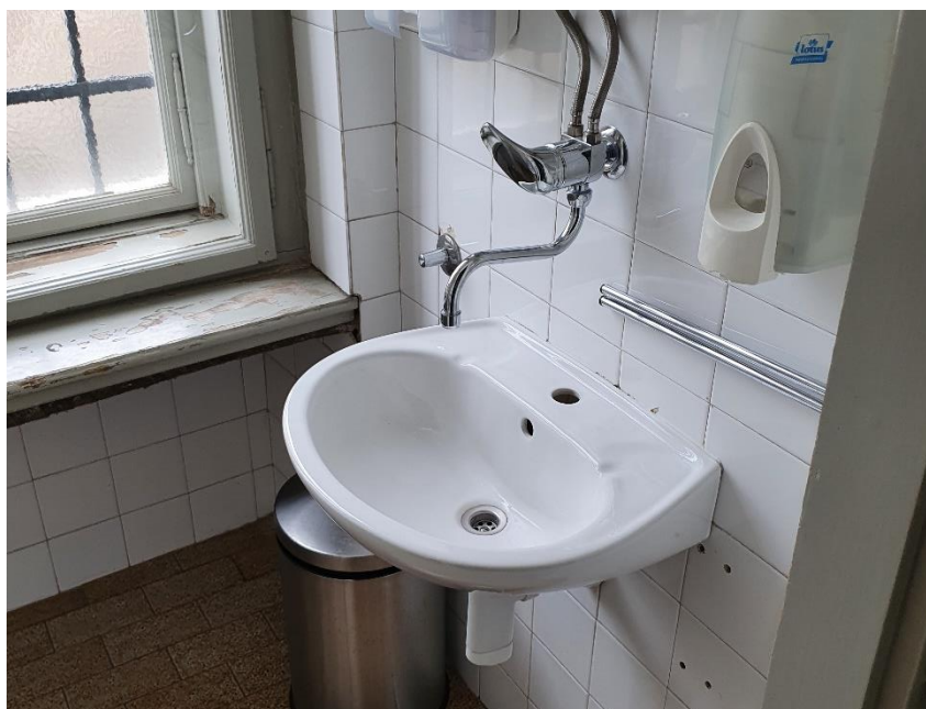
Slika 35: Umivaonica sa jednoručnom mješalicom vode
