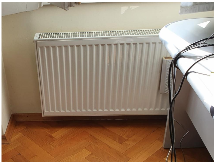
Slika 19: Čelični pločasti radijator
