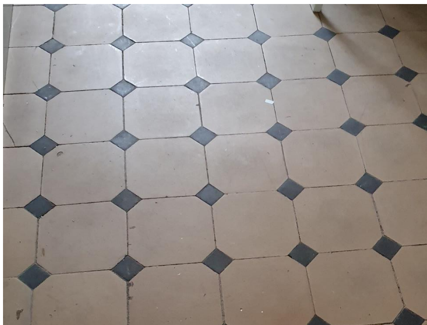
Slika 8: Detalj podne obloge od keramičkih pločica
