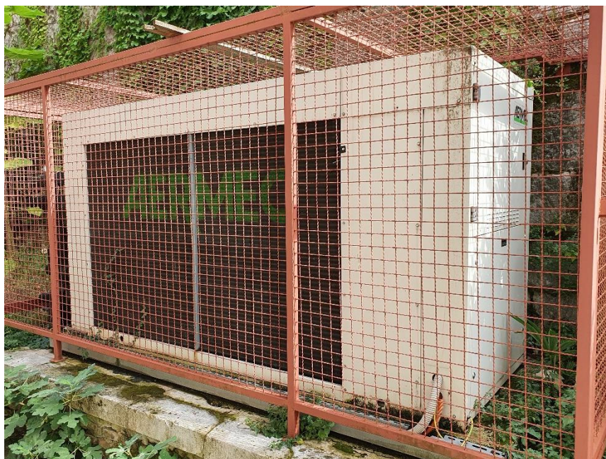
Slika 17: Dizalica topline u okolišu zgrade
