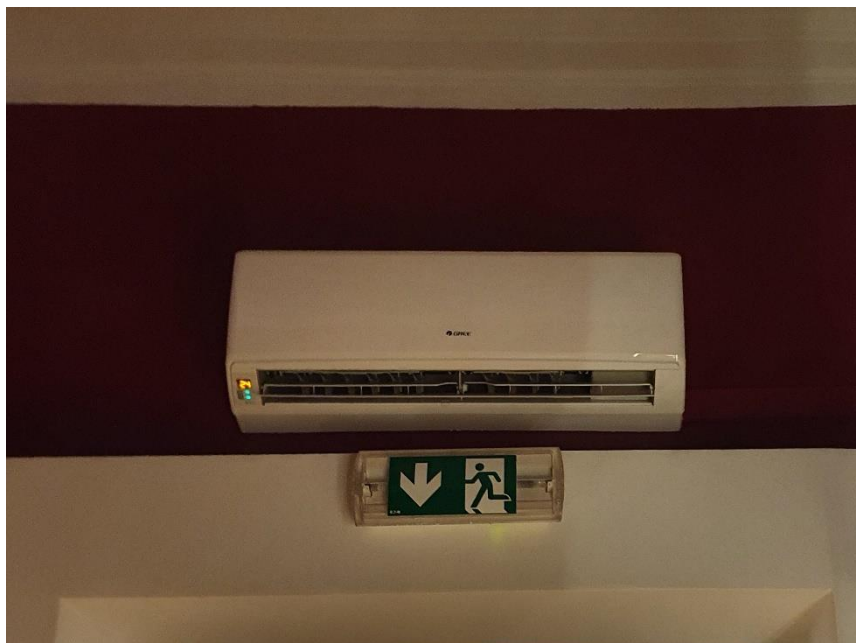
Slika 21: Unutarnja zidna jedinica split sustava
