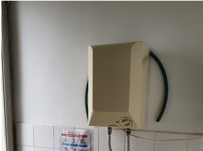
Slika 23: Električni bojler za pripremu potrošne tople vode
