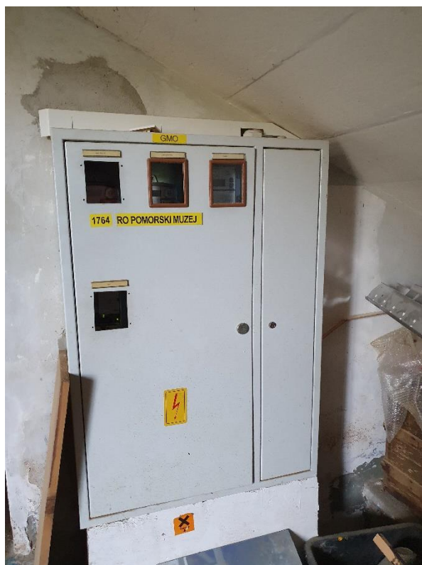
Slika 24: Glavni mjerni ormar
