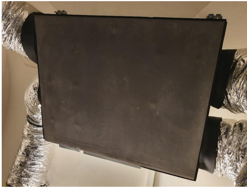
Slika 22: Rekuperatorska jedinica
