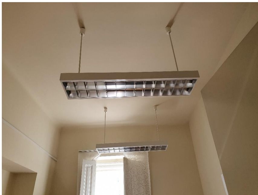
Slika 30: Viseća rasvjetna tijela sa fluo cijevima
