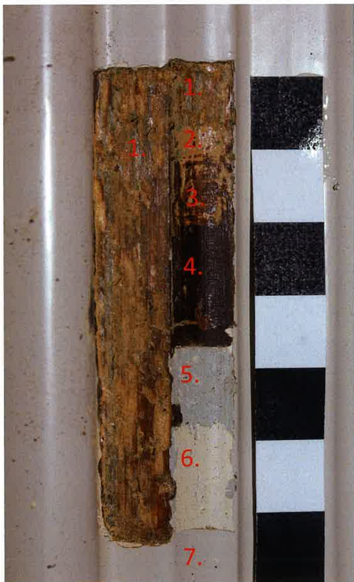
Detalji sonde 12 otvorene izvan Žutog salona, ustanovljen plavo sivi prvi nalič
