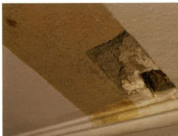
Detalj sonde 4, profilirani vijenac i stropna ploha
