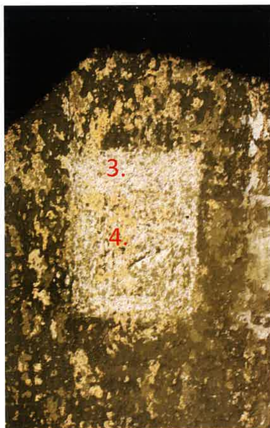
Detalj sonde 10, bijela podloga i oker ličeni sloj
