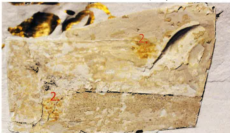
Detalj dodatka sonde 6, na štuko reljefu i zidu, močenjem površine bolje je vidljiva prisutnost oker ličenog sloja
