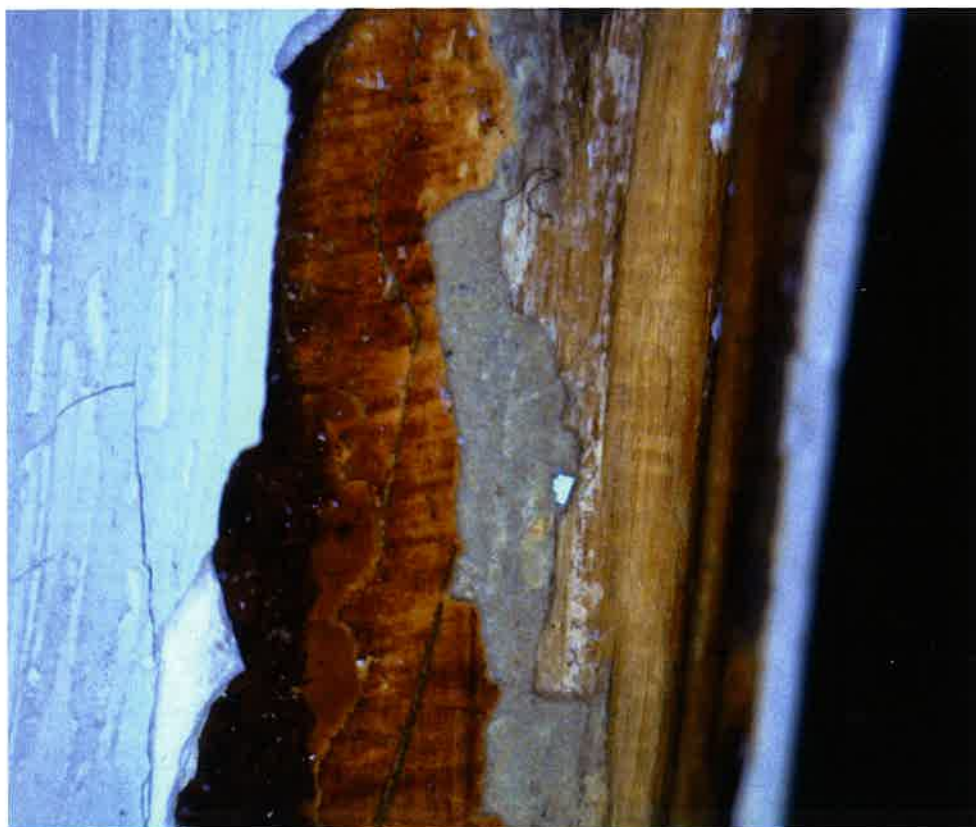
Slika 7, Detalj snimljen na bočnoj strani balkonskih vrata, iznad mjesta uzimanja uzorka 7 snimljeni slojevi: drveni nosilac (0), plavo sivi nalič (1), fladrani nalič boje mahagonija (2), fladrani nalič tamno smeđe boje (3), sivi nalič (4), sivi nalič (5)
