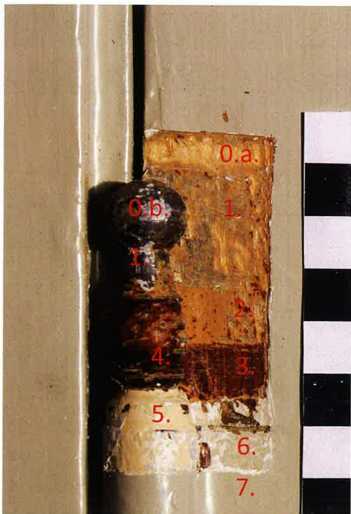
Detalj sonde 9, povijesni naliči jednako su nanesen i na metalni i na drveni nosilac
