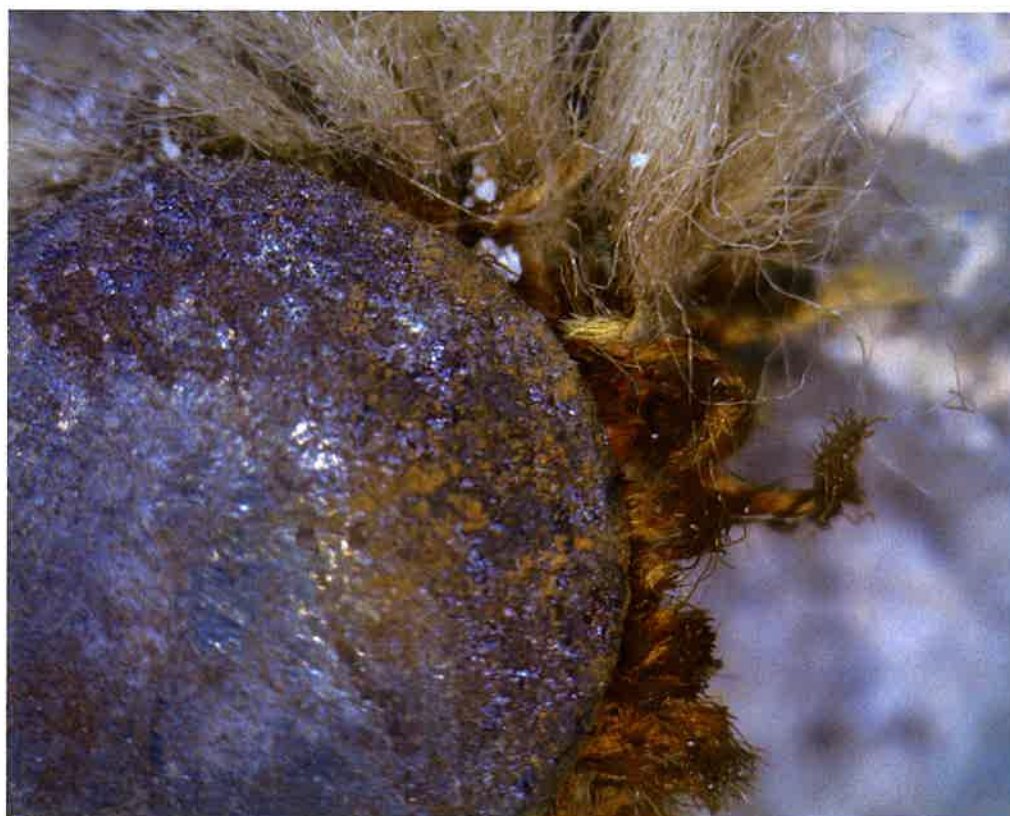
Slika 12, Detalj snimljen na mjestu uzimanja Uz 1, glava metalnog čavla i ostaci zlatne tkanine koja sadrži vlakna svile i pamuka, tkanina pripada nekom od povijesnih slojeva nakon druge crvene papirnate tapete, a prethodi posljednjem sloju tekstilnih zlatnih tapeta
