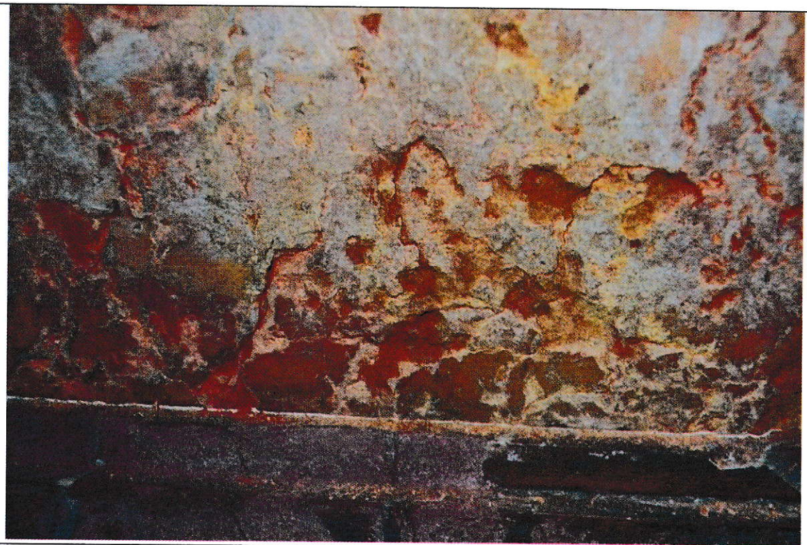
Sl. 7 Razlistavanje površine mramora Rosso Verona – detalj na sjevernom zidu
