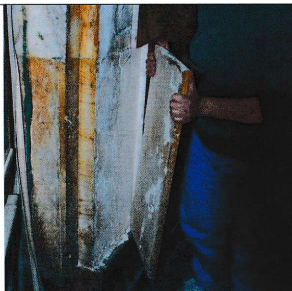
Sl. 38 Demontaža nestabilne ploče sa istočnog zida
