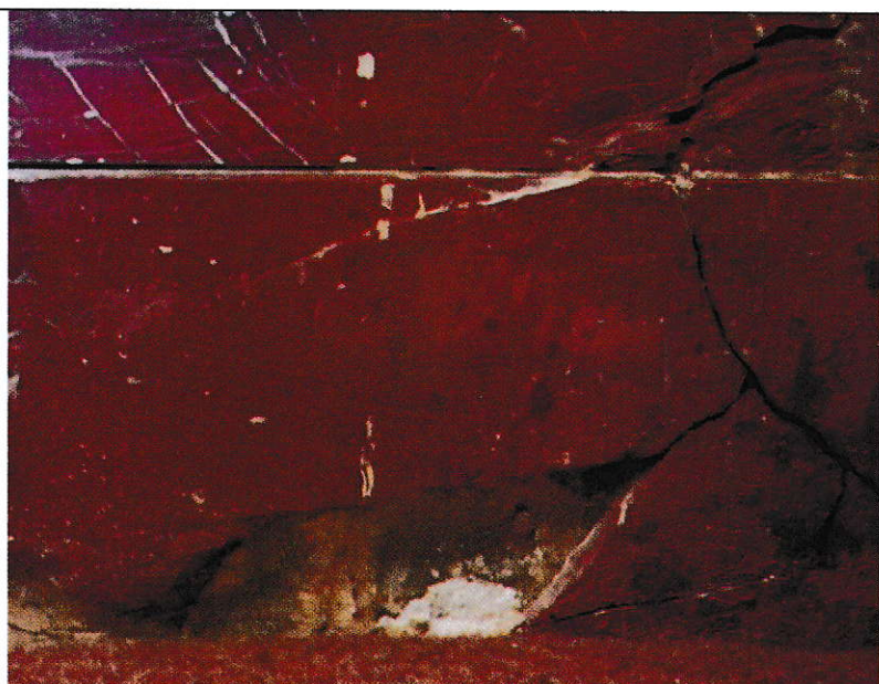
Sl. 10 Pucanje i odlamanje djelovanjem gravitacijskih sila
