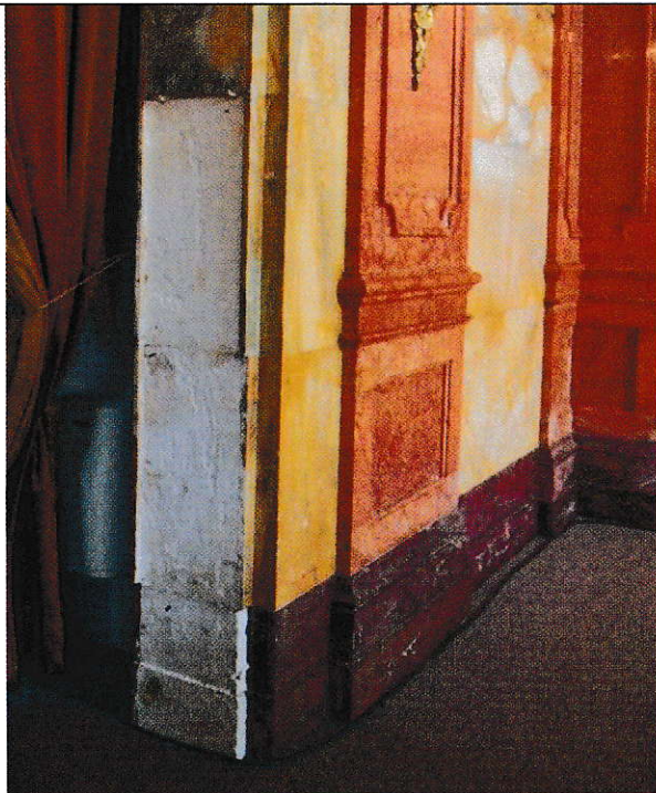
Sl. 13 Ploče koje su se vremenom odvojile od podloge su već ranije demontirane i uskladištene
