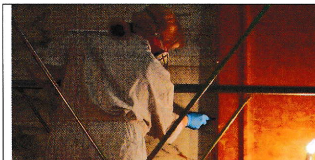
Sl. 57 Čišćenje zaostalih ljepila i zakita Toluenom i skalpelom
