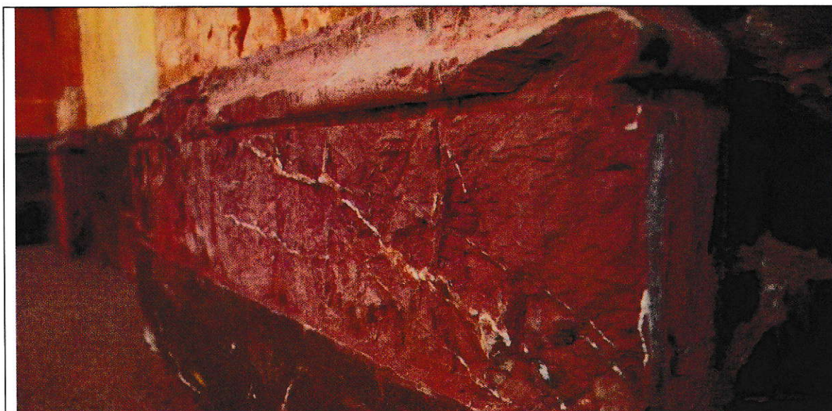
Sl. 6 Degradacija mramora Rosso Sicilia uzrokovana solima- detalj na sjevernom zidu
