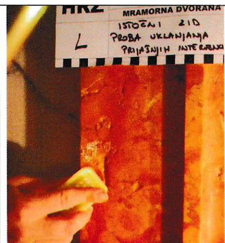
Sl. 60 Dočišćavanje zapuna plastičnim četkicama
