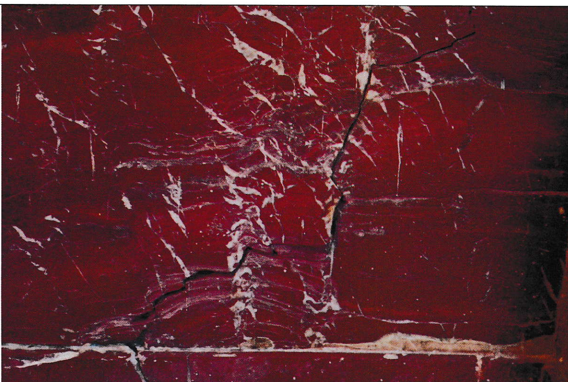
Sl. 12 Pukotina uzrokovana gravitacijskim silama na oslabljen mramor Rosso Sicila
