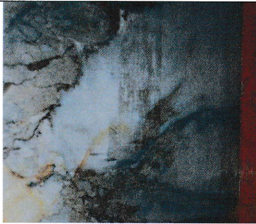
Sl. 29 Površinske prljavštine nastale neispravnim korištenjem mramora
