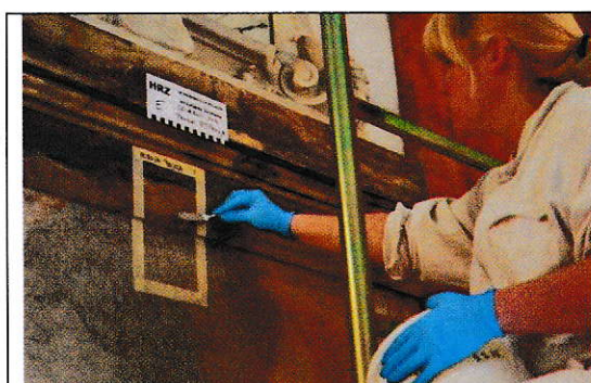
Sl. 57 Proba čišćenja Morovom pastom na sjevernom zidu, nanašanje špatulicama
