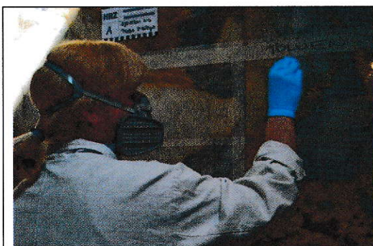
Sl. 51 Proba uklanjanja nečistoća Toluenom
