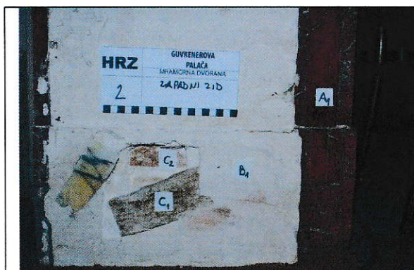
Sl. 39 Sonda na bočnom dijelu zapadnog pregradnog zida
