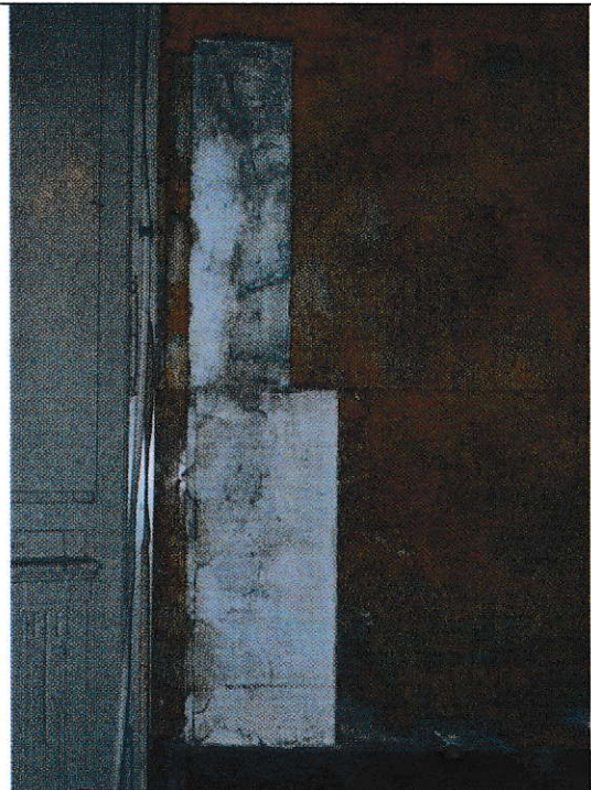
Sl. 14 Prilikom istraživanja demontirale su se ove mramorne ploče jer su prijetile ispadanjem
