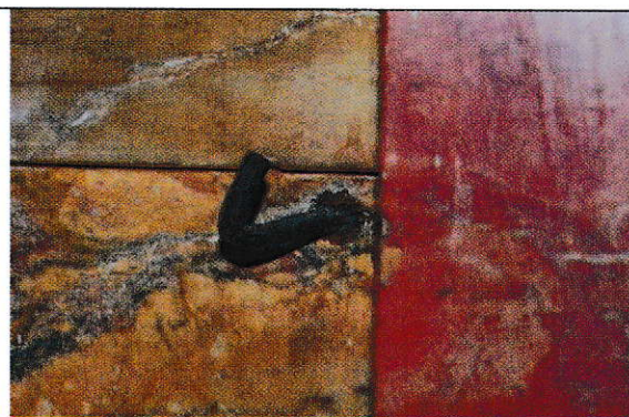
Sl. 18 Željezni element ugrađen u drvenu posteljicu
