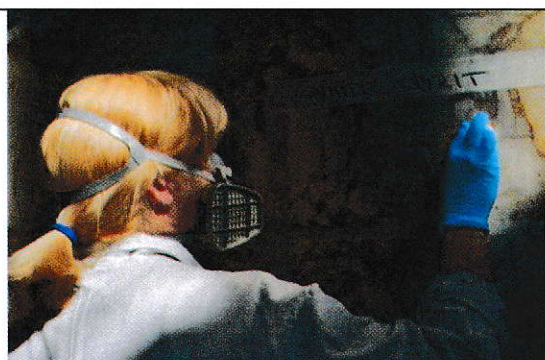
Sl. 52 Proba čišćenja mramorne površine White Spirit-om
