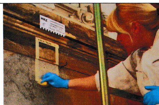
Sl. 46 Nakon 3 do 5 minuta, pasta se uklanja mokrom spužvicom
