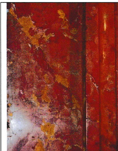
Sl. 23 Zatečena domodelacija sitnih oštećenja na mramoru Rosso Verona – detalj
